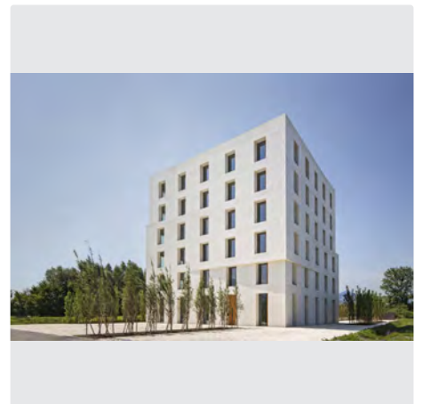
baumschlagler eberle Bürogebäude 2226 | Office Block 2226 | Lustenau Photos: Eduard Hueber
